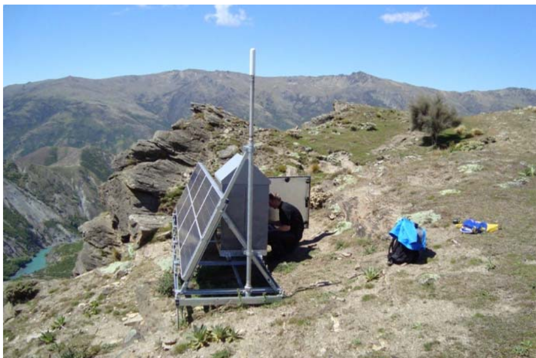
图D-5：采用新能源的ADS-B地面站
